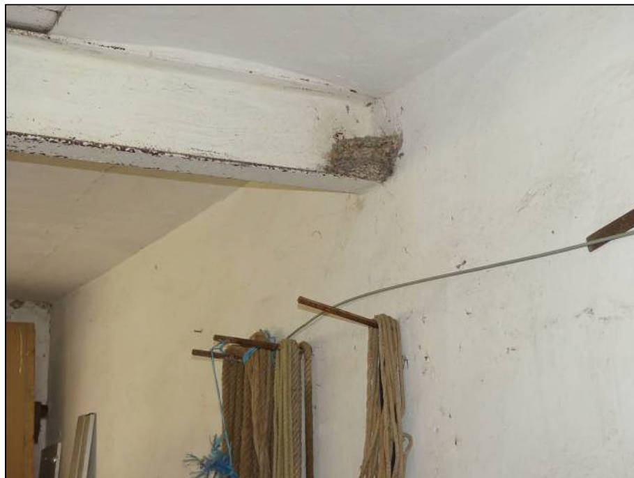
Abb. 8 Altes Schwalbennest im ehemaligen Stallbereich des zum Abriss vorgesehenen landwirtschaftlichen Gebäude (30.06.2021)
